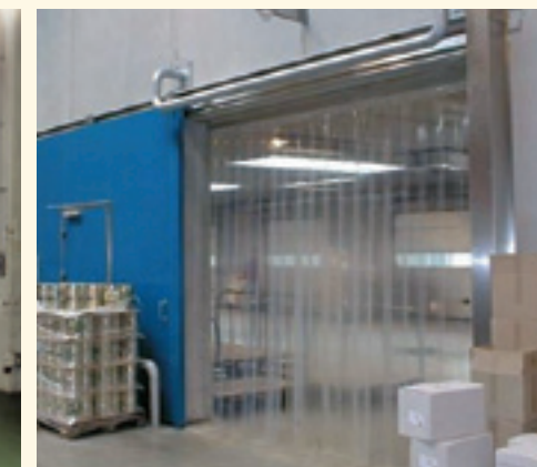
■倉庫内の間仕切（冷蔵） ⑯
