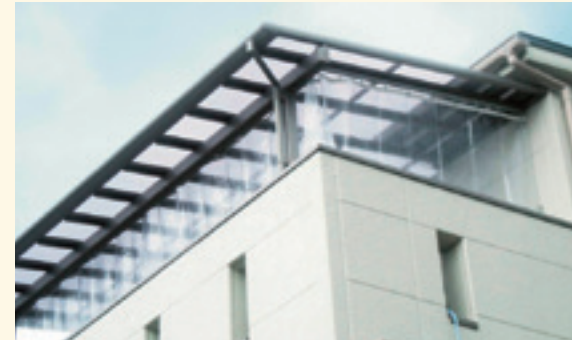
雨・風除け 防塵 ビニールシート、D30レール使用
