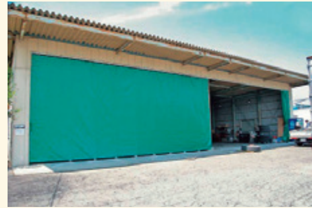
■倉庫開口部 雨・風除け 防塵 テントシート、XGレール、間仕切ポール使用
