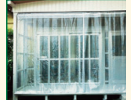
雨・風除け 防塵 ビニールシート、D40レール使用
