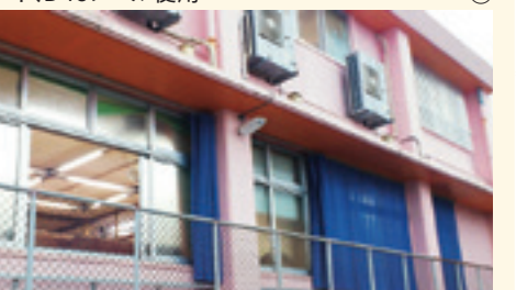
屋上施設 雨風除け 防塵 テントシート、XGレール使用 ㉔
