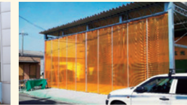
雨・風除け 防塵 防虫 ビニールシート(防虫)、D40レール、間仕切ポール使用
