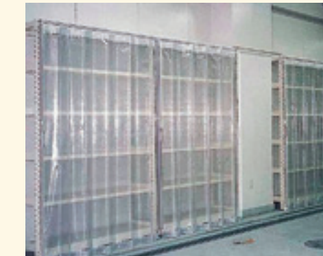
防塵 ビニールシート、D30レール、間仕切ポール使用 ⑫
