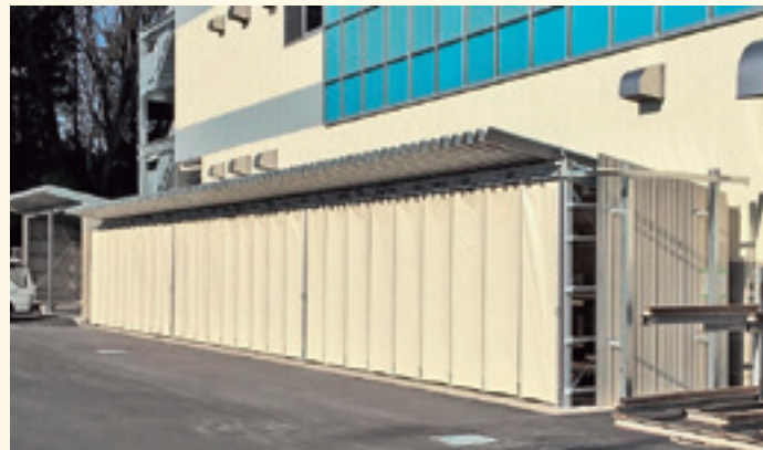
雨・風除け 防塵 テントシート、D40レール、間仕切ポール使用
