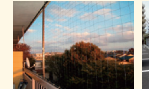
南・西側窓 窓日除け メッシュシート、D40レール使用 ⑲
