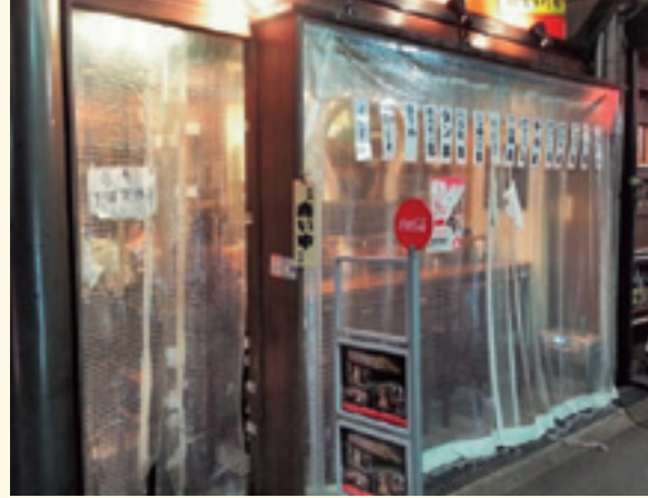
防塵 保温・保冷 雨・風除け ビニールシート、D40レール使用
