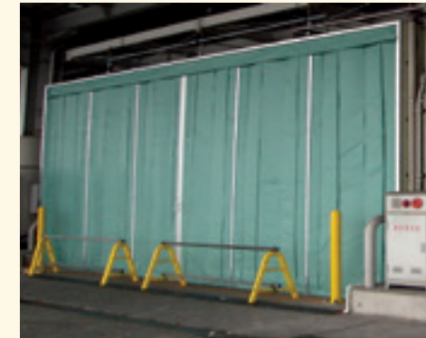
断熱(冷蔵) 断熱シート、D40レール、間仕切ポール使用 ⑨
