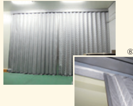
製品棚 防塵 ビニールシート、D30レール、間仕切ポール使用 ⑩
