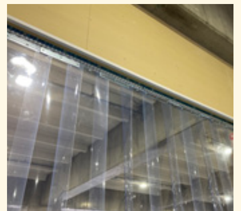
■物流センター内の間仕切 ⑳
