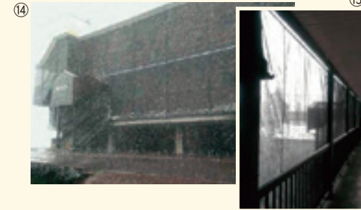
マンションベランダ 防鳥 防鳥ネット、D30レール、間仕切ポール使用 ⑯
