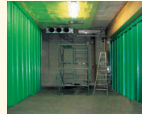
断熱(冷蔵) 断熱シート、D40レール、間仕切ポール使用 ⑧
