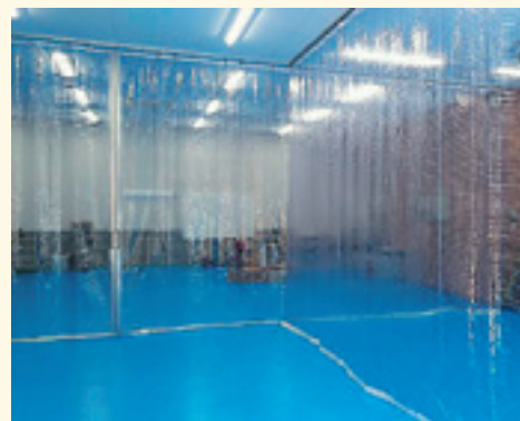
保温・保冷 飛散防止 防塵 ビニールシート、D40レール、間仕切ポール使用 ②
