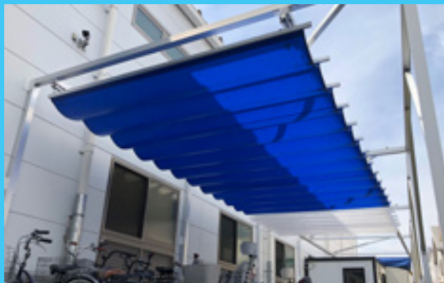
●駐輪場の雨除け
