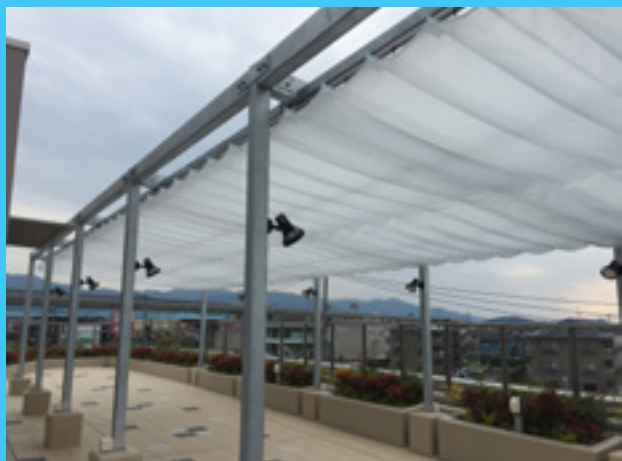
●共用部通路の雨除け
