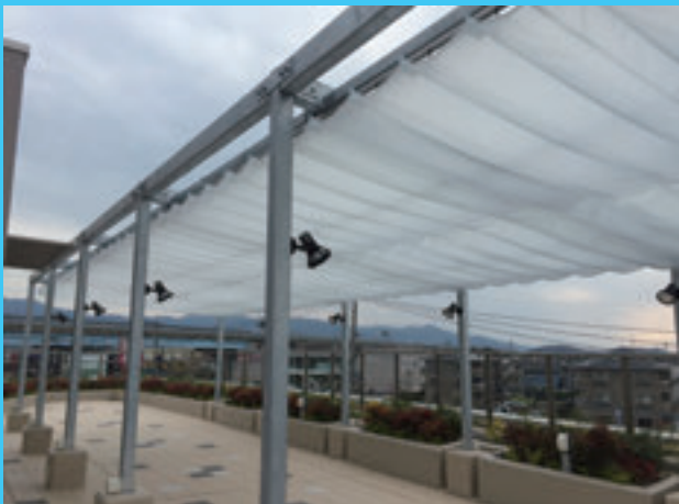
●共用部通路の雨除け
